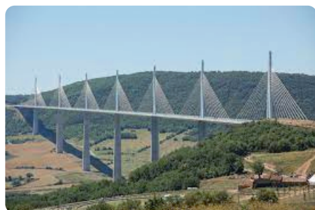
Le viaduc de Millau
